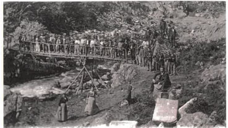
L'aspect, photo, Sallandrouze Barrage des COMBES, sur la Creuse, près Aubusson Travaux préliminaires - Entrée des ouvriers dans le chantier
